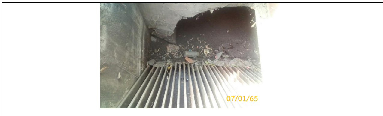
รูปที่ 25 ตะแกรงดักขยะที่บ่อพักสุดท้ายก่อนระบายน้ำลงสู่ท่อระบายน้ำสาธารณะ
