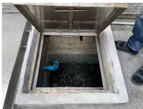
ภาพที่ 8 ถังเก็บน้ำใต้ดินอาคารสโมสร
