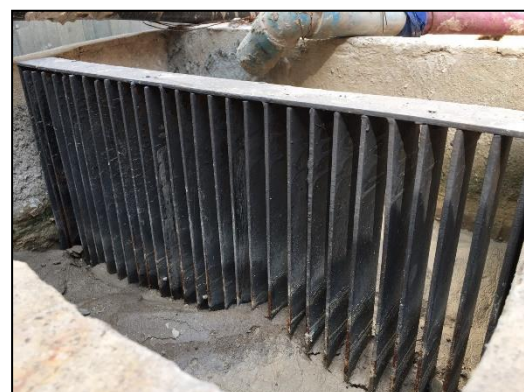
ภาพที่ 31 ตะแกรงคัดขยะ
