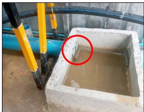
ภาพที่ 24 บ่อพักน้ำ และตะแกรงดักขยะ
