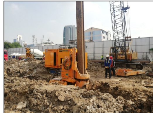
ภาพที่ 19 การกด Sheet Pile
