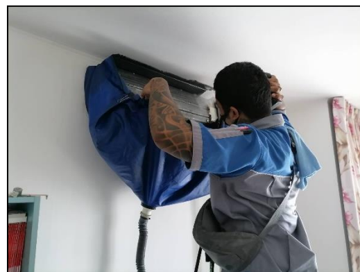
ภาพที่ 56 ล้างเครื่องปรับอากาศของคอนโด ยูดีไลท์ แอท จตุจักร
