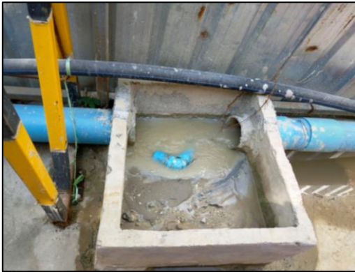
ภาพที่ 28 ท่อน้ำและบ่อพักน้ำชั่วคราว
