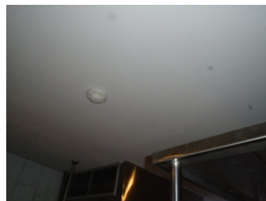
ภาพที่ 5-34 เครื่องตรวจจับความร้อนในห้องครัว
