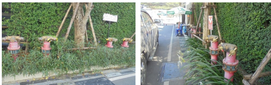
ภาพที่ 5-30 หัวรับน้ำดับเพลิงจากภายนอกส่วนโรงแรม และส่วนสรรพสินค้าพาณิชย์
