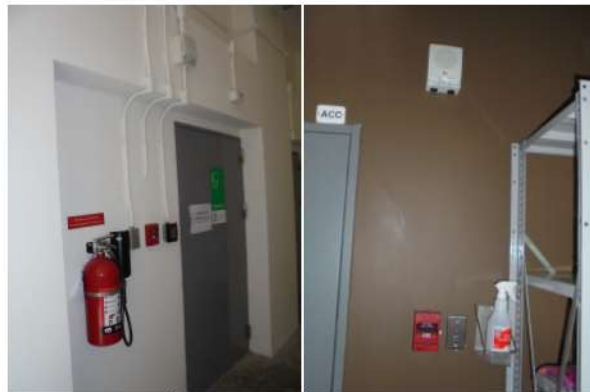
ภาพที่ 3-22 อุปกรณ์สัญญาณเตือนอัคคีภัยและดับเพลิง
