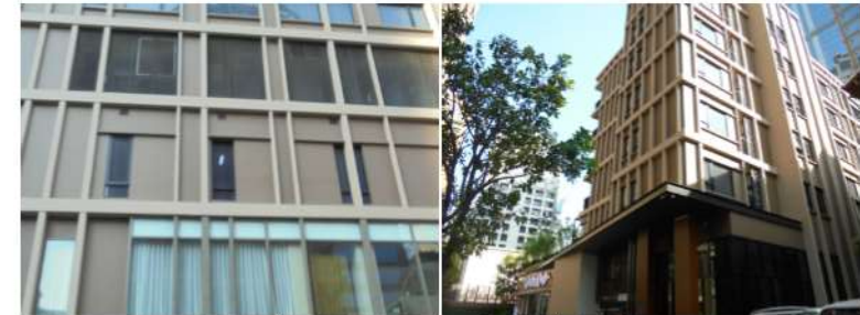
ภาพที่ 3-29 ช่องเปิดระบายอากาศของโครงการหน้าต่างระแนง
