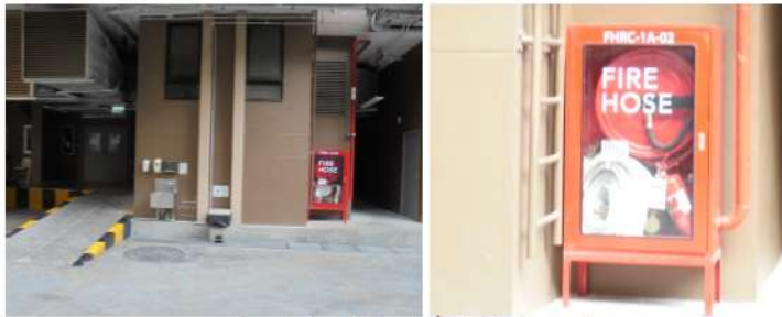
ภาพที่ 3-21 ท่อขึ้นและตู้เก็บสายฉีดน้ำดับเพลิงพร้อมอุปกรณ์
