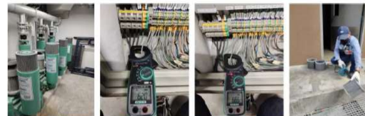
ตรวจสอบเครื่องเติมอากาศรุ่น SDB-75 AB-01 AB-03 AB-04 สามารถทำงานได้เป็นปกติ
