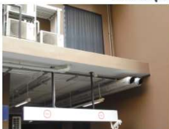
ภาพที่ 3-17 ท่อไอเสียจากห้องไฟฟ้าถูกแก้ไข ปลดออกมาตรงกับต้นไม้ยืนต้นข้างรั้วโครงการ
