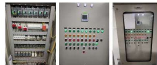
ตรวจสอบตู้ควบคุมระบบน้ำดับน้ำเสียพบว่าทำงานได้เป็นปกติ
