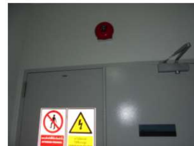
ภาพที่ 3-18 ป้ายเตือนอันตราย และกึ่งสัญญาณดับเพลิงติดไว้หน้าห้องไฟฟ้า
