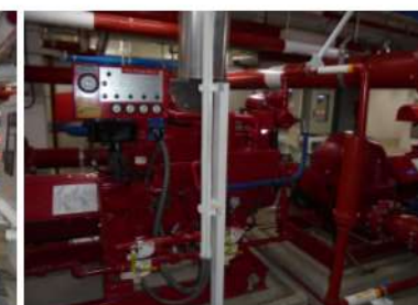
ภาพที่ 3-20 ห้องเครื่องสูบน้ำดับเพลิง
