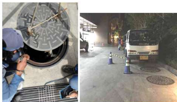
ภาพที่ 3-39 ดูปตะกอนจากระบบบำบัดน้ำเสีย และบำรุงรักษาอย่างสม่ำเสมอ
