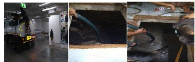
ดูตะกอนจากท่อพักตะกอนที่โรงแรม สินธรเคมปินัส ภาพที่ 4-39 ดูตะกอนจากท่อพักตะกอนของอาคาร
