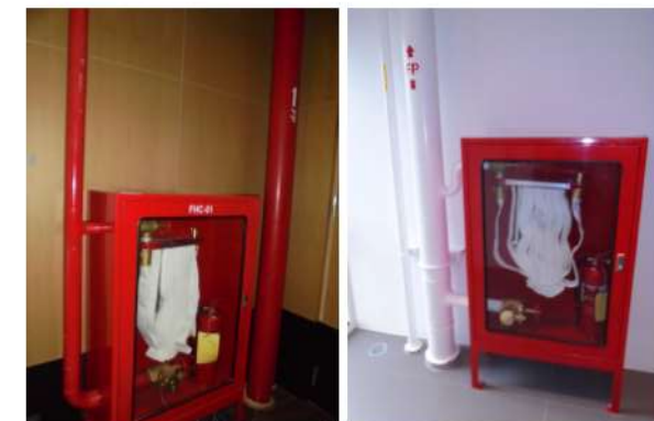
ภาพที่ 3-18 ตู้เก็บสายฉีดน้ำดับเพลิงพร้อมอุปกรณ์
