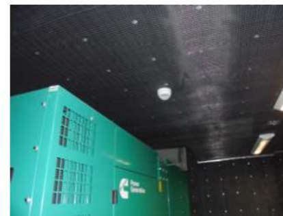
ภาพที่ 3-12 ห้องเครื่องไฟฟ้าฉุกเฉิน บัด้วยวัสดุกันเสียง
