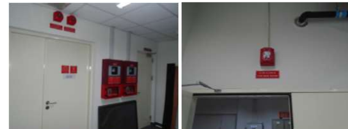
ภาพที่ 2-23 ชุดอุปกรณ์แจ้งเหตุโดยใช้มือดึง กริ่งสัญญาณเตือนภัย และโทรศัพท์ฉุกเฉิน
