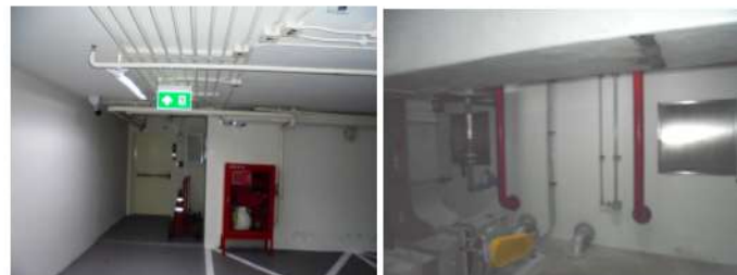
ภาพที่ 2-21 ตู้เก็บสายขึ้นนำดับเพลิงพร้อมอุปกรณ์ และท่อขึ้น
