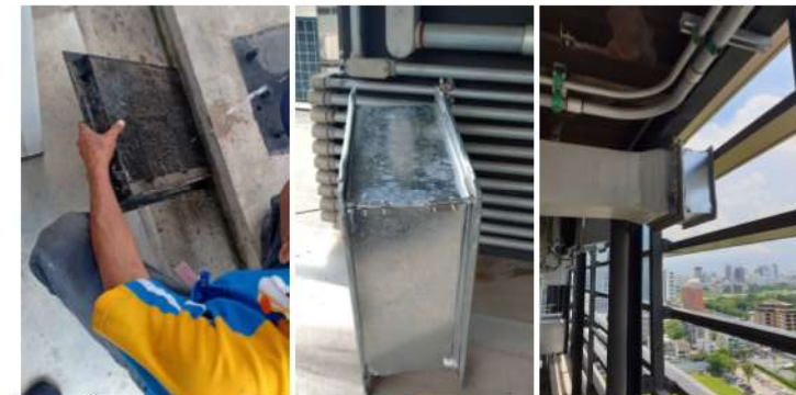
ภาพที่ 2-35 ติดตั้ง ถังกรองบรรจุ Activated Carbon และแผ่น Filter สำหรับกักน้ำอัด Aerosol และดูแลรักษาโดยคนผ่านแผ่น Filter นำมาล้าง
