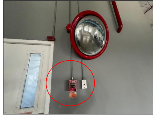
รูปที่ 1-21 อุปกรณ์แจ้งเหตุเพลิงไหม้
