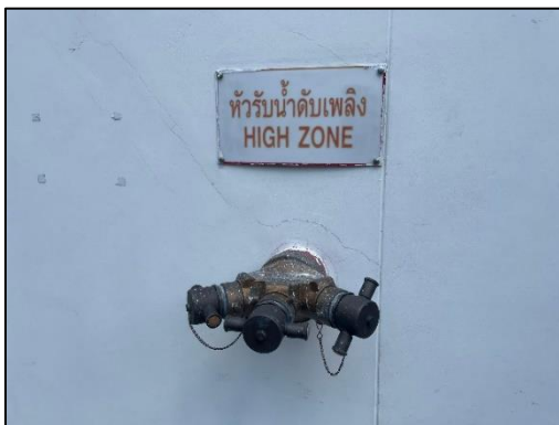
รูปที่ 1-24 หัวรับน้ำดับเพลิงภายนอกอาคารส่วน HIGH ZONE
