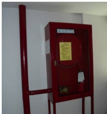
ภาพที่ 4-23 ตู้เก็บสายฉีดน้ำดับเพลิงพร้อมอุปกรณ์
