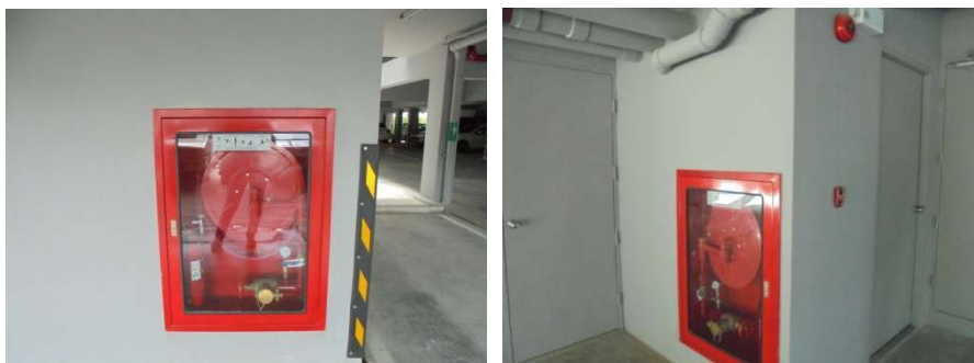
ภาพที่ 4-29 ระบบท่อเย็นพร้อมตู้เก็บอุปกรณ์ดับเพลิง
