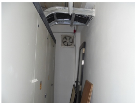
ภาพที่ 4-32 พัดลมระบายอากาศบริเวณห้องต่างๆที่ไม่มีช่องเปิดระบายอากาศ
