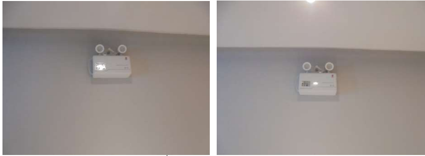
ภาพที่ 4-27 ไฟฟ้าส่องสว่างฉุกเฉิน
