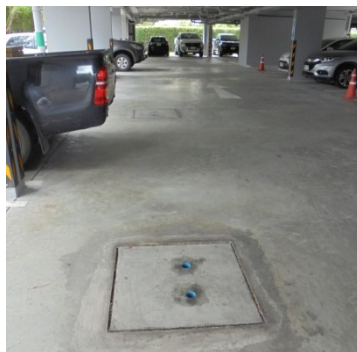
ภาพที่ 4-22 แนวท่อระบายน้ำและฝาท่อเป็นฝาคอนกรีต
