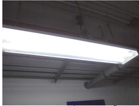
ภาพที่ 3-9 ตัวอย่างหลอดไฟส่องสว่างภายในโครงการใช้หลอดฟลูออเรสเซนต์ที่เป็นหลอดผอมทั้งหมด
