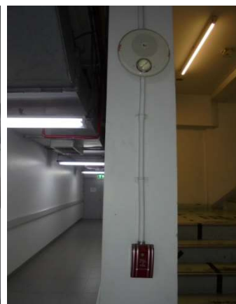
ลิฟต์ดับเพลิง เครื่องส่งสัญญาณโดยใช้มือดึง
