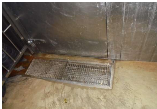
ภาพที่ 3-13 รางระบายน้ำภายในห้องพัสดุฝอยรวม
