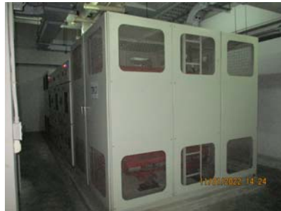
รูปที่ 31 หม้อแปลงไฟฟ้าชนิด Dry Type Cast Resin
