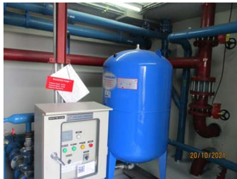
รูปที่ 53 การสูบน้ำจากถังเก็บน้ำใต้ดิน ไปพักยังถังเก็บน้ำชั้นห้องเครื่อง
