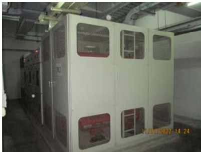
รูปที่ 31 หม้อแปลงไฟฟ้าชนิด Dry Type Cast Resin
