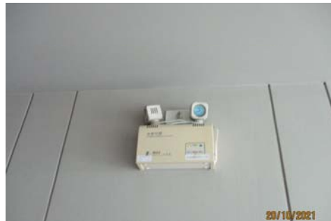
รูปที่ 32 ระบบไฟฟ้าฉุกเฉิน
