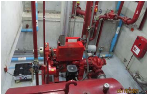
รูปที่ 16 ระบบสูบน้ำภายในโครงการ
