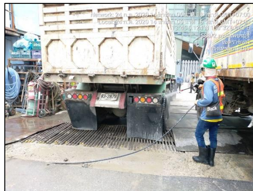
ภาพที่ 28 ล้างล่อนก่อนออกจากพื้นที่โครงการ
