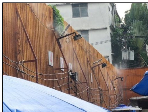
ภาพที่ 12 ติดตั้งสเปรย์น้ำบริเวณรั้ว Metal Sheet
