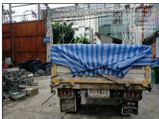
ภาพที่ 13 ปิดคลุมกระบะรถบรรทุกด้วยผ้าใบ
