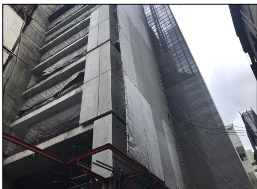
ภาพที่ 10 ผนังคอนกรีตสำเร็จรูป (Pre-Cast)
