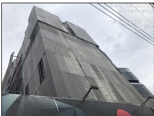
ภาพที่ 9 ผ้าใบกันฝุ่น (Mesh Sheet)
