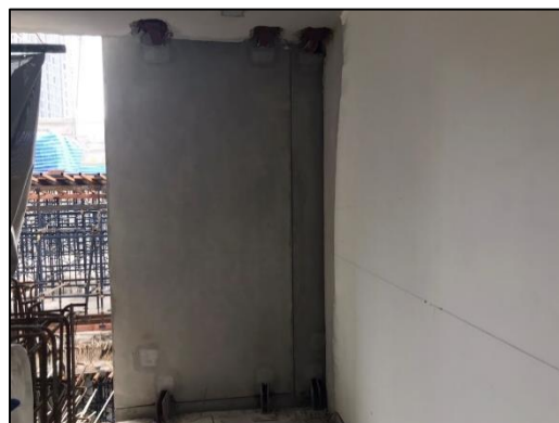
ภาพที่ 10 ผนังคอนกรีตสำเร็จรูป (Pre-Cast)
