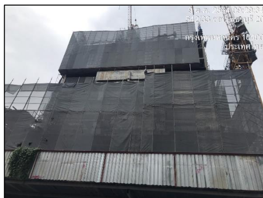
ภาพที่ 9 ผ้าใบกันฝุ่น (Mesh Sheet)
