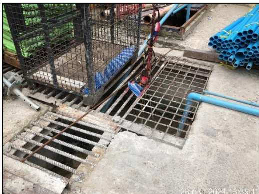
ภาพที่ 27 บ่อดักตะกอน และตะแกรงดักขยะ
