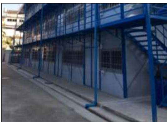
ภาพที่ 71 รางระบายน้ำฝน และน้ำทิ้ง บริเวณบ้านพักคนงาน
