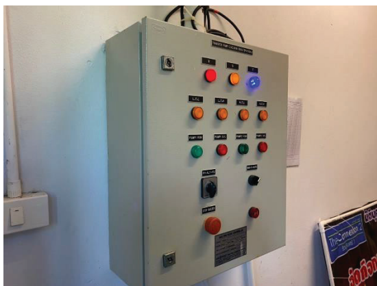
รูปที่ 5 ระบบสูบน้ำในอาคาร
