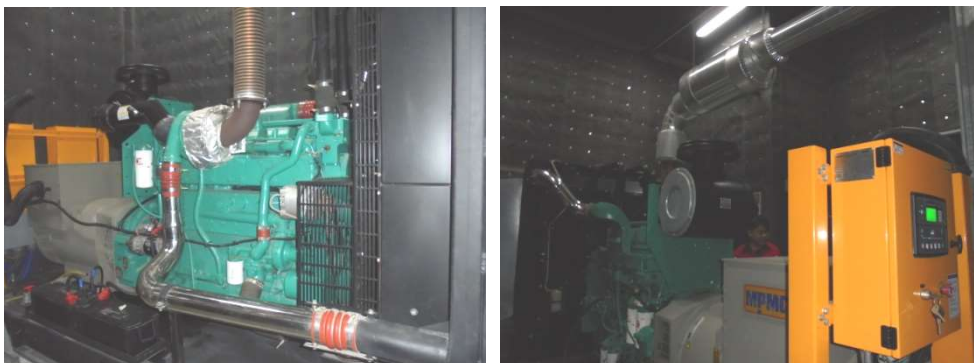
ภาพที่ 3-5 ห้องเครื่องกำเนิดไฟฟ้าสำรอง
