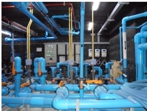
ภาพที่ 3-13 เครื่องสูบน้ำประปา
