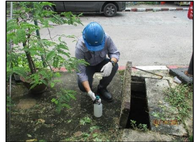
บ่อฟักน้ำทิ้งที่ออกจากถังตกตะกอนก่อนระบายออกสู่ภายนอกโครงการ รูปที่ 3-2 แสดงการเก็บตัวอย่างน้ำทิ้ง เดือนตุลาคม 2564
