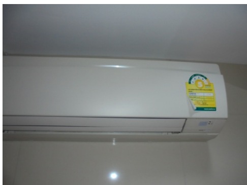
ภาพที่ 3-35 เครื่องปรับอากาศใช้แบบประหยัดไฟเบอร์ 5
