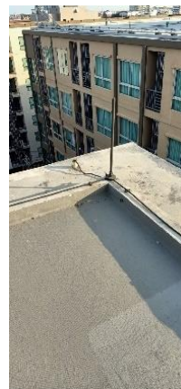
ภาพที่ 1-27 ภาพระบบป้องกันฟ้าผ่าของอาคารโครงการ
