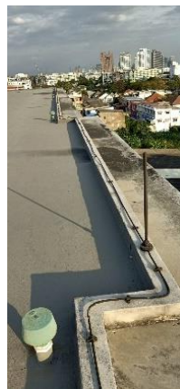
ภาพที่ 1-27 ภาพระบบป้องกันฟ้าผ่าของอาคารโครงการ
