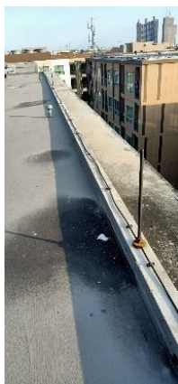
ภาพที่ 1-27 ภาพระบบป้องกันฟ้าผ่าของอาคารโครงการ
