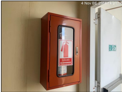
ภาพที่ 22 ถังดับเพลิงแบบมือถือ
