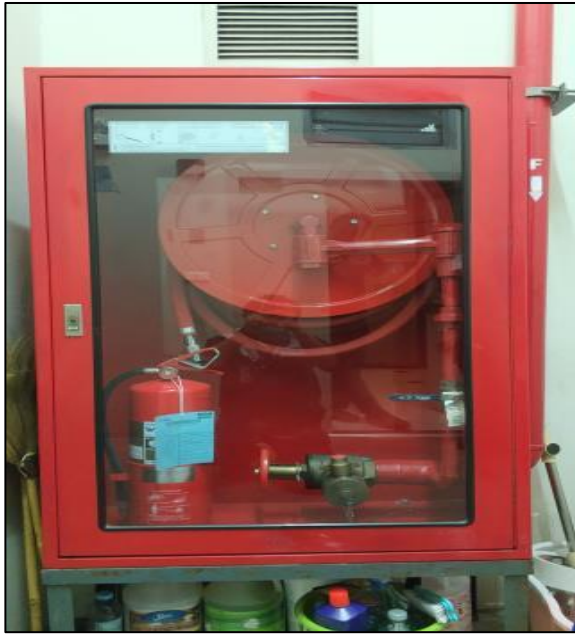
ภาพที่ 27 ตู้สายฉีดน้ำดับเพลิง
