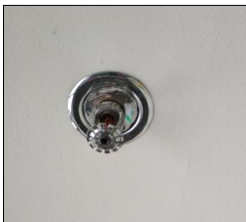
ภาพที่ 29 ระบบดับเพลิงแบบกระจายกระจายน้ำอัตโนมัติ
