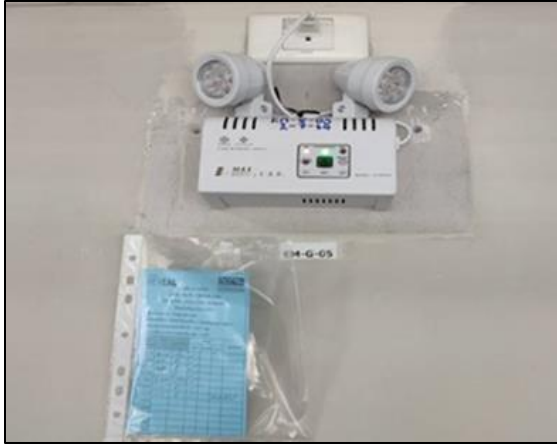
ภาพที่ 12 ตรวจสอบอุปกรณ์เครื่องไฟฟ้าสำรองและสายไฟ
