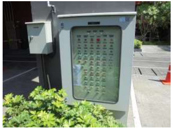
รูปที่ 8 ตู้ควบคุมบำบัดน้ำเสีย
