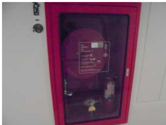
รูปที่ 32 ถังดับเพลิงเคมีแบบถือในตู้ FHC
