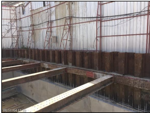
ภาพที่ 6 ระบบค้ำยัน/ระบบป้องกันดินพัง
