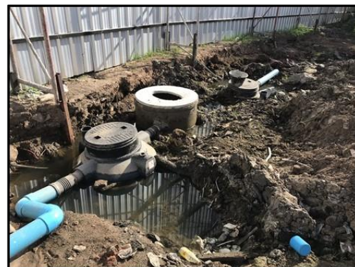
ภาพที่ 39 ระบบบำบัดน้ำเสีย
