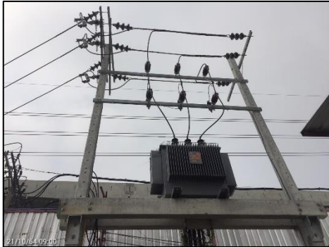
ภาพที่ 28 หม้อแปลงไฟฟ้า
