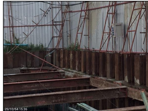
ภาพที่ 6 ระบบค้ำยัน/ระบบป้องกันดินพัง
