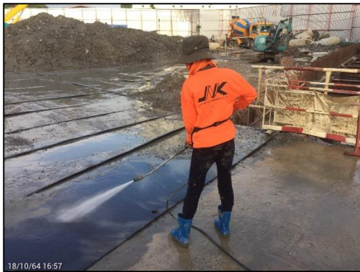
ภาพที่ 11 คนงานฉีดพรมน้ำพื้นที่โครงการ
