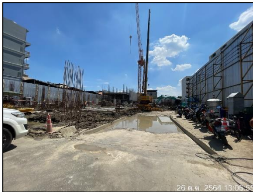
ภาพที่ 15 แผ่นเหล็กหนาปูบริเวณทางเข้า-ออก โครงการ
