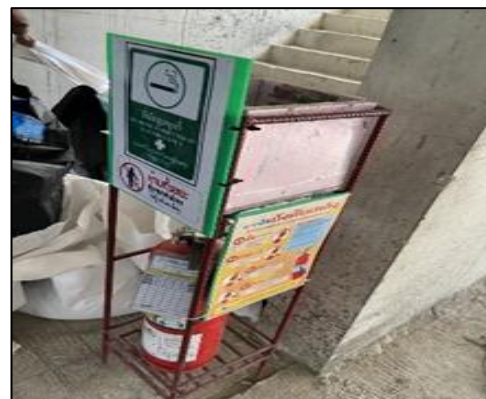
ภาพที่ 36 ถังดับเพลิงเคมีและป้ายแนะนำการใช้งาน
