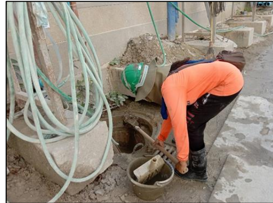
ภาพที่ 44 ขุดลอกตะกอนรางระบายน้ำ
