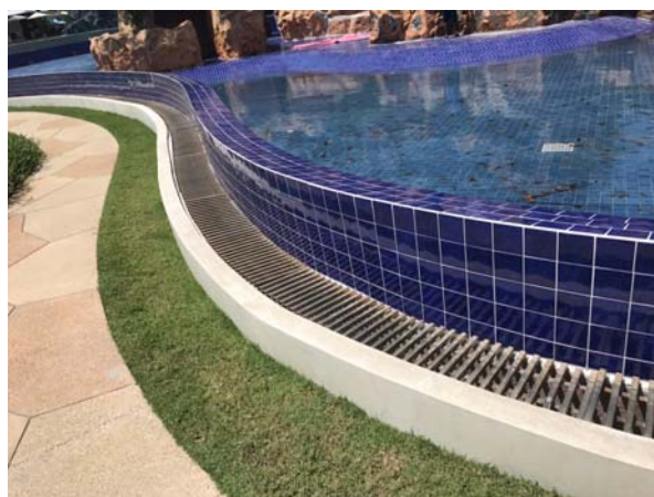
รูปที่ 3-36 รางระบายน้ำล้นของสระว่ายน้ำ
