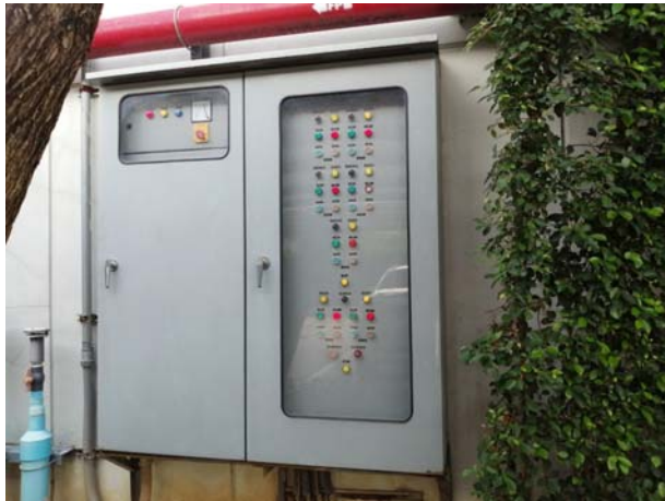
รูปที่ 3-8 ระบบมิเตอร์ไฟฟ้าของระบบบำบัดน้ำเสีย
