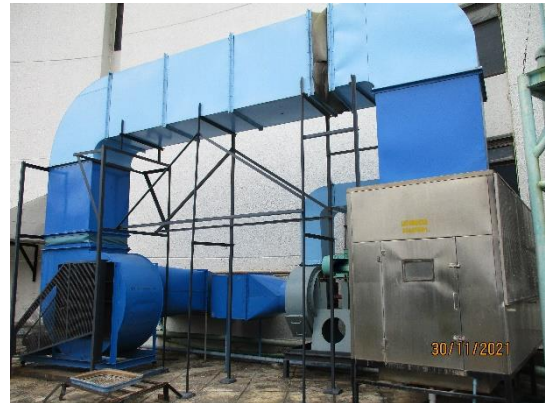
(2) ระบบดักจับใยผ้าโดยใช้น้ำ
