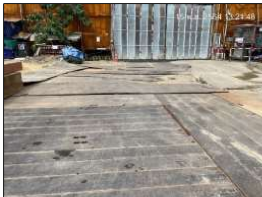
ภาพที่ 31 ปูแผ่นเหล็กบริเวณพื้นที่ก่อสร้าง
