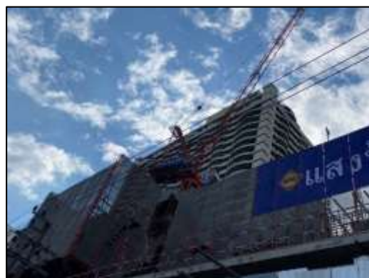
ภาพที่ 65 Mesh Sheet ปิดคลุมโดยรอบอาคาร
