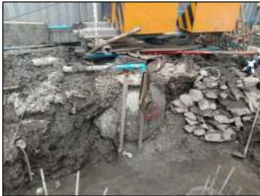
ภาพที่ 38 ถังบำบัดน้ำเสียสำเร็จรูป
