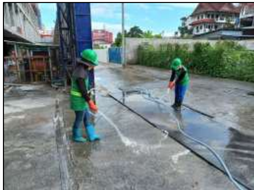
ภาพที่ 7 คนงานฉีดพรมน้ำบริเวณพื้นที่ก่อสร้าง
