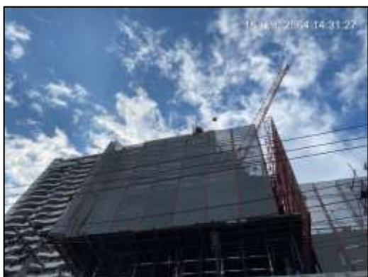
ภาพที่ 65 Mesh Sheet ปิดคลุมโดยรอบอาคาร
