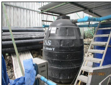
รูปที่ 1-3 ระบบบำบัดน้ำเสียสำเร็จรูปชั่วคราว
