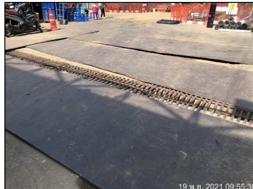
ภาพที่ 13 ปูแผ่นเหล็กภายในพื้นที่โครงการ
