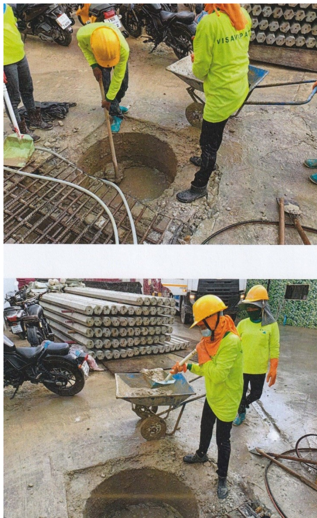
5-12 ล้างทำความสะอาดท่อพักตะกอนและท่อระบายน้ำ
