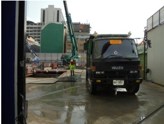
5-8 ชีตล้างล้อรถบรรทุกก่อนออกจากโครงการด้วยสายฉีดน้ำแรงดันสูง
