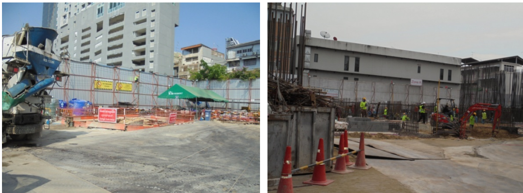
5-4 ปูแผ่นเหล็กหนาบริเวณพื้นที่โครงการ และราวกันตกช่วงการขุดดิน
