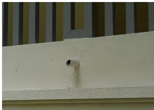
รูปที่ 2.27 รางระบายน้ำจากอาคาร
