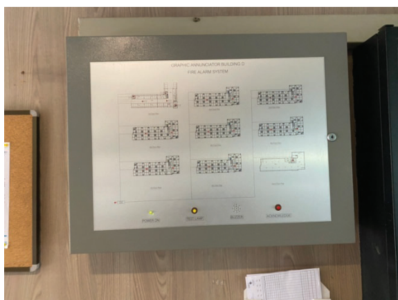
รูปที่ 15 แผงควบคุมระบบสัญญาณแจ้งเหตุเพลิงไหม้
