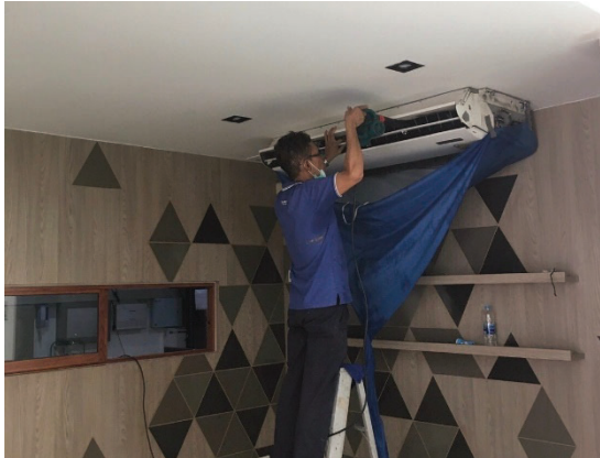
รูปที่ 47 การล้างทำความสะอาดเครื่องปรับอากาศ ในพื้นที่ส่วนกลาง
