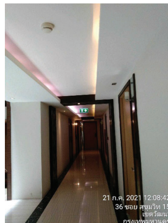
รูปที่ 4 เครื่องตรวจจับควัน
