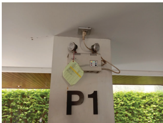
รูปที่ 3 ระบบไฟฟ้าฉุกเฉิน
