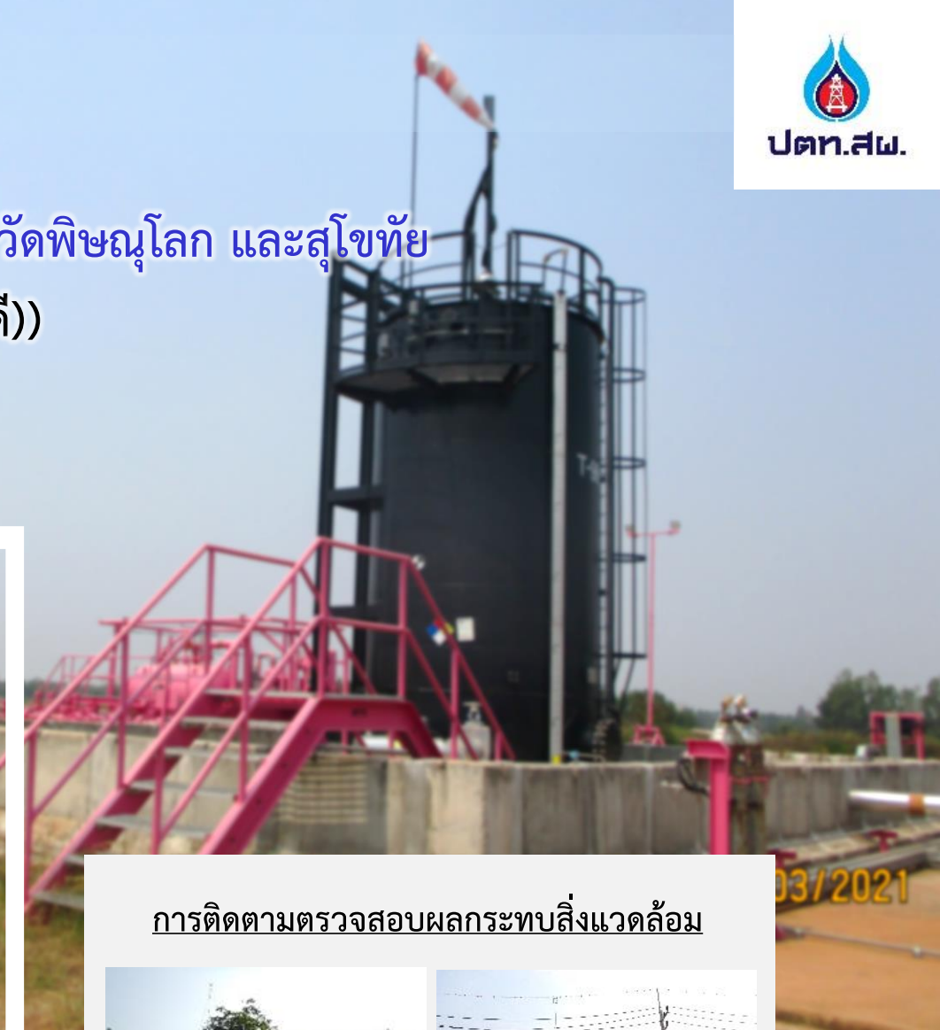
การติดตั้งอุปกรณ์บนฐาน คอนกรีตมีรางระบายน้ำล้อมรอบ
