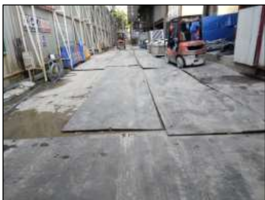
ภาพที่ 69 ปูแผ่นเหล็กบริเวณพื้นที่ก่อสร้าง
