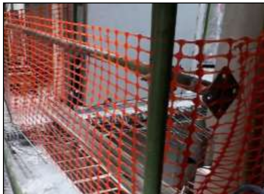
ภาพที่ 67 แผงเหล็กถักพร้อมตาข่าย
