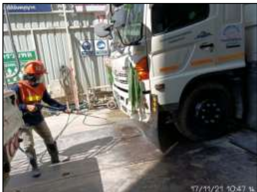
ภาพที่ 68 พนักงานฉีดล้างล้อรถบรรทุก
