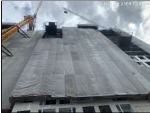
ภาพที่ 14 ผ้าใบ Mesh Sheet
