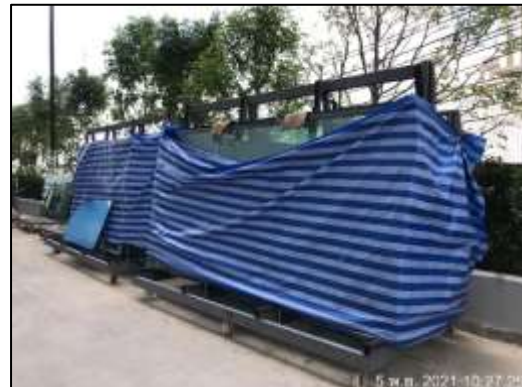
ภาพที่ 4 ผ้าใบปิดคลุมกองวัสดุก่อนสร้าง
