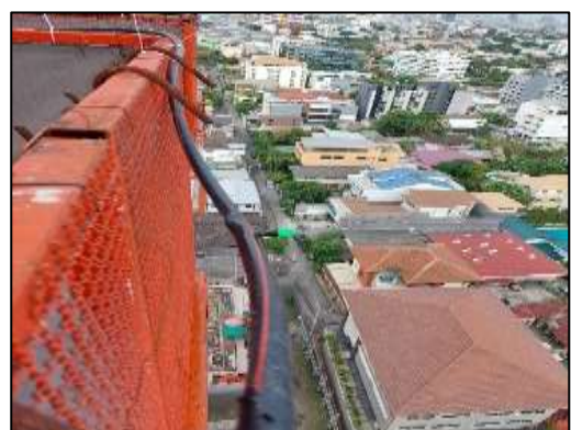
ภาพที่ 10 ม่านละอองน้ำบนโครงสร้าง Mesh Sheet
