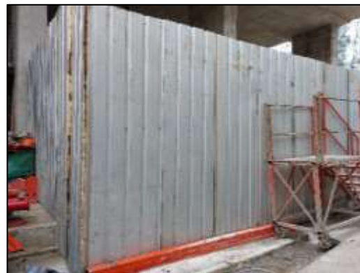
ภาพที่ 12 กำแพงกันเสียงและพื้นที่ทำกิจกรรมที่เกิดมลภาวะ
