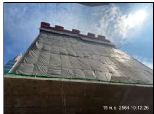
ภาพที่ 9 Mesh Sheet ปิดคลุมอาคาร
