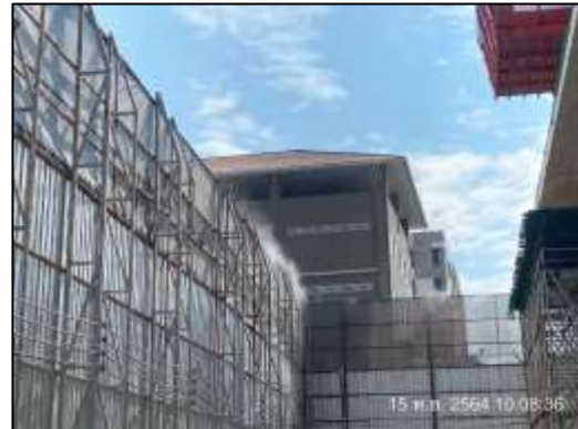
ภาพที่ 11 ม่านละอองน้ำบริเวณรั้ว Metal Sheet
