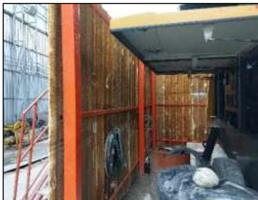
ภาพที่ 12 กำแพงกันเสียงและพื้นที่ทำกิจกรรมที่เกิดมลภาวะ
