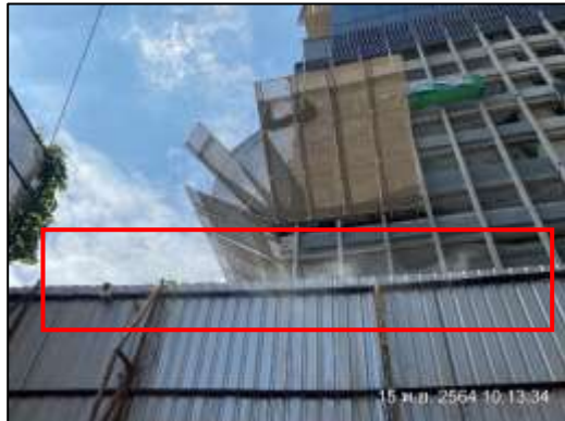
ภาพที่ 11 ม่านละอองน้ำบริเวณรั้ว Metal Sheet
