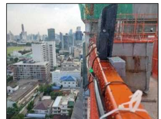
ภาพที่ 10 ม่านละอองน้ำบนโครงสร้าง Mesh Sheet
