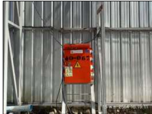
ภาพที่ 35 ตู้ไฟฟ้าชั่วคราว พร้อมติดป้ายเตือนความเสี่ยง
