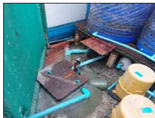
ภาพที่ 18 ถังบำบัดน้ำเสียสำเร็จรูป
