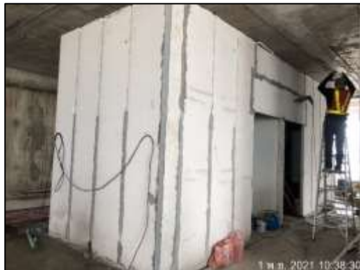
ภาพที่ 11 Precast Wall
