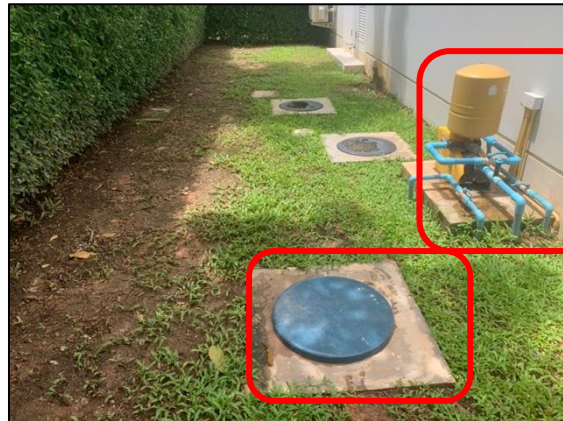
เครื่องสูบน้ำใช้และถังเก็บน้ำใต้ดิน
