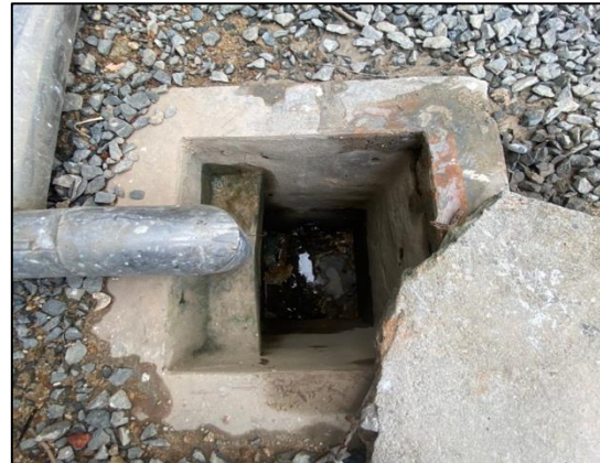
ระบบระบายน้ำฝนจากหลังคาหลังคาปล่อยพัก
