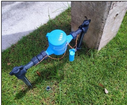
ระบบมิเตอร์น้ำประปาประจำแต่ละแปลง
