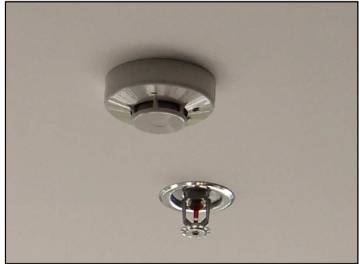
ภาพที่ 2-8 Smoke Detector & Sprinkler
