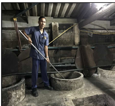
ภาพที่ 2-2 บ่อดักไขมัน , เจ้าหน้าที่ดูและระบบบำบัดน้ำเสียและดักไขมันออกจากบ่อดักไขมันและถูกดำนบรรจุไขมัน
