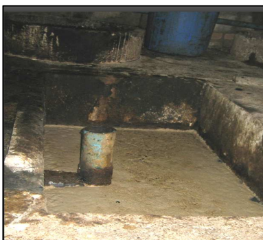
ภาพที่ 2-2 บ่อดักไขมัน , เจ้าหน้าที่ดูและระบบบำบัดน้ำเสียและดักไขมันออกจากบ่อดักไขมันและถูกดำนบรรจุไขมัน
