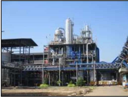
รูปที่ 2-9 ถังหมัก หอกด้น และหอกลั่นน้ำที่เป็นระบบปิด
