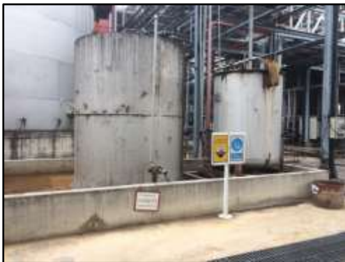
รูปที่ 2-39 ถังเก็บ NaOH
