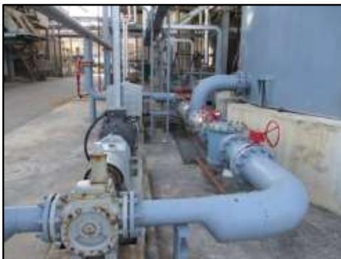
รูปที่ 2-37 ปัมป์สูบลกากน้ำตาล
