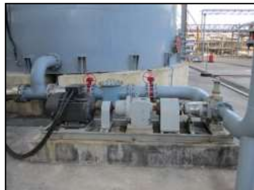
รูปที่ 2-37 ปัมป์สูบลกากน้ำตาล
