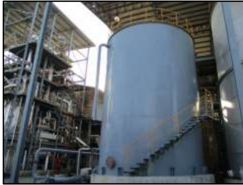
รูปที่ 2-36 ถังเก็บกากน้ำตาล
