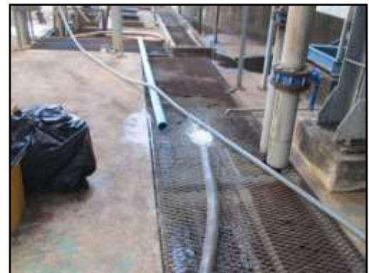
รูปที่ 2-18 รางระบายน้ำเสียภายในพื้นที่โครงการ
