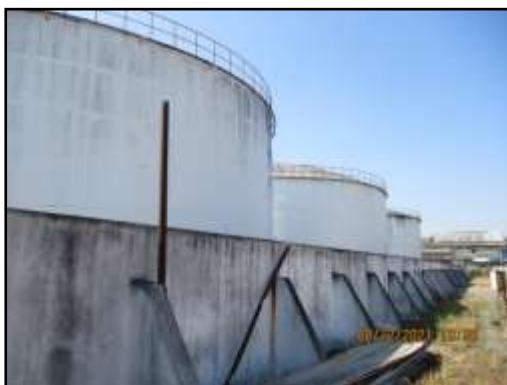
รูปที่ 2-34 คั่นคอนกรีตล้อมรอบถังเก็บเอทานอล
