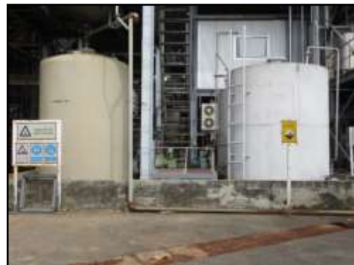
รูปที่ 2-40 ถังเก็บ H_2SO_4
