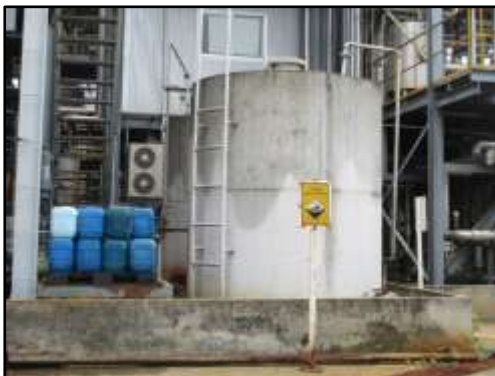
รูปที่ 2-40 ถังเก็บ H_2SO_4
