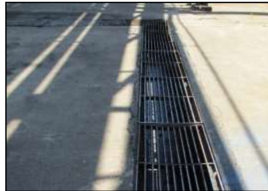
รูปที่ 2-17 รางระบายน้ำฝนรอบพื้นที่โครงการ
