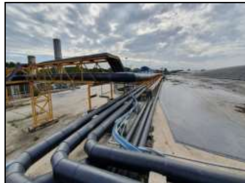
รูปที่ 2-38 ท่อที่ใช้ในการลำเลียงก๊าซชีวภาพของโครงการเป็นท่อ HDPE PE100/PN10
