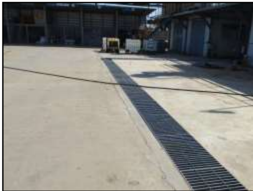
รูปที่ 2-17 รางระบายน้ำฝนรอบพื้นที่โครงการ
