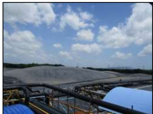
รูปที่ 2-4 พลาสติก HDPE ปิดคลุมบ่อพักน้ำเสียของโครงการ
