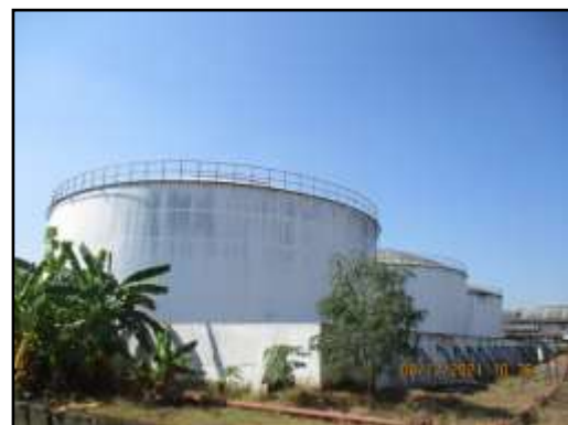
รูปที่ 2-34 คั่นคอนกรีตล้อมรอบถังเก็บเอทานอล
