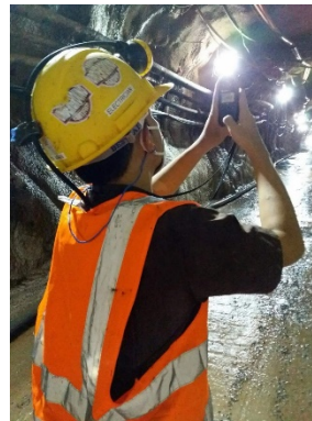
รูปที่ 2-70 ตรวจสอบด้วยเครื่องมือตรวจวัดปริมาณอากาศป้อนเข้าสู่หน้างาน
