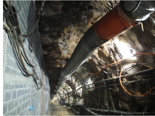
รูปที่ 2-68 ติดตั้งท่อระบายอากาศชนิดอ่อน (Spiral Duct) เชื่อมต่อไปถึงบริเวณปฏิบัติงาน
