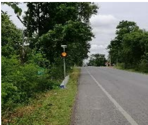
รูปที่ 2-83 การติดตั้งสัญญาณไฟกระพริบ บริเวณทางเชื่อมเข้าสู่ทางหลวงหมายเลข 205
