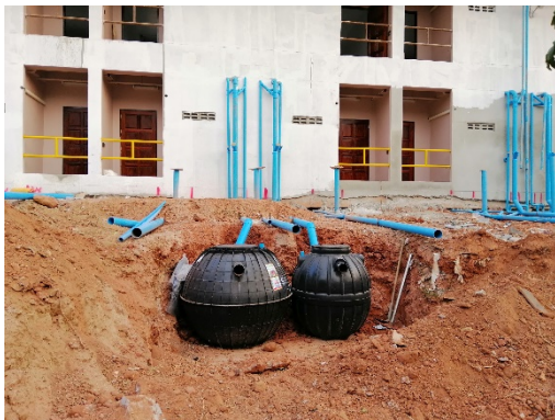
รูปที่ 2-9 ติดตั้งถังบำบัดน้ำเสียเบื้องต้นสำหรับ อาคารต่างๆ ก่อนปล่อยน้ำลงสู่แหล่งน้ำในพื้นที่ โครงการ
