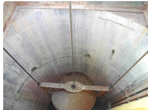
รูปที่ 2-64 หล่อผนังคอนกรีตปิดผนึกทางน้ำ บริเวณภายในอุโมงค์แนวตั้ง
