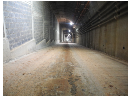
รูปที่ 2-56 ก่อสร้างพื้นอุโมงค์สร้างด้วยคอนกรีต เสริมเหล็กสามารถรองรับน้ำหนักเครื่องจักรหนักได้
