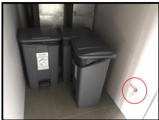
รูปที่ 2-28 ห้องพักขยะมีก๊อกรน้ำและท่อระบายน้ำสำหรับทางน้ำไหล
